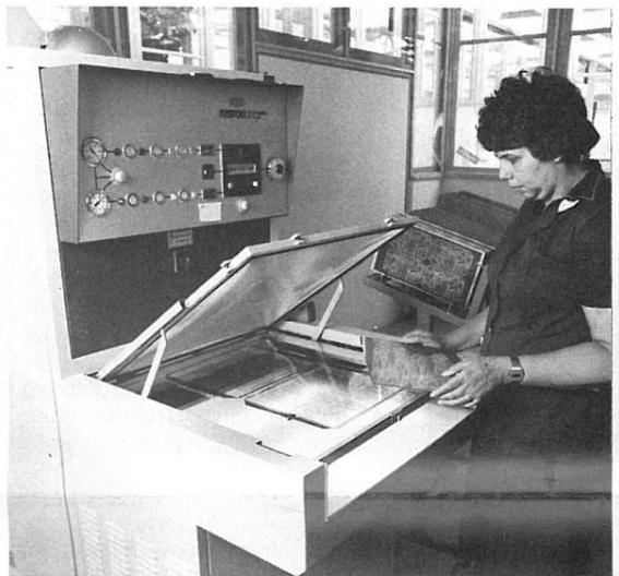
5. Mit UV-Licht werden die beschichteten Leiterplatten im Kontakt mit den Fotoplotterfilmen belichtet (polymerisiert)...
