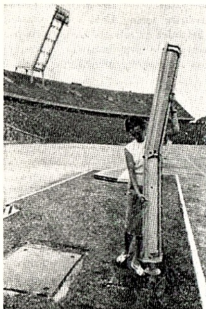
Rys. 10. Osadzanie kolumny dźwiękowej do nagłośnienia stadionu sportowego
