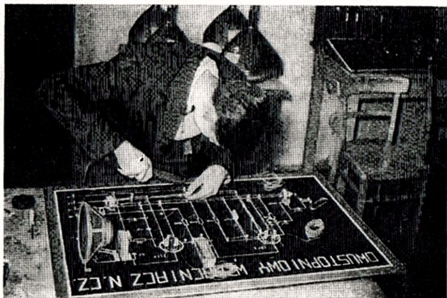
Budowa 2-stopniowego wzmacniacza m.cz. na zawodach radiomechaników
