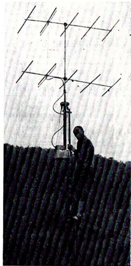
Rys. 2. SP5IB instaluje antenę Yagi
