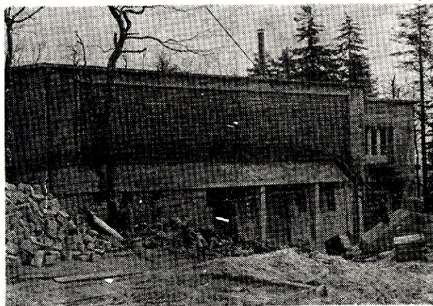
Budynek nadawczej stacji telewizyjnej w Sobótce pod Wrocławiem
