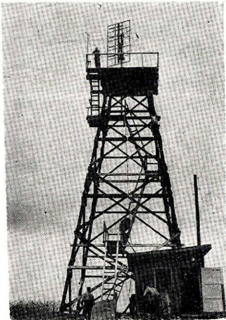
Budowa telewizyjnej stacji retransmisyjno-przekaznikowej w Mosinie pod Poznaniem. Stacja ta umożliwi nadawanie w Poznaniu programu warszawskiego poprzez Katowice-Wrocław
