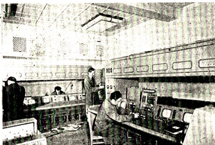
Prace przy instalowaniu aparatury telewizyjnej ośrodka transmisyjnego w Pałacu Kultury i Nauki (fot. CAF).
