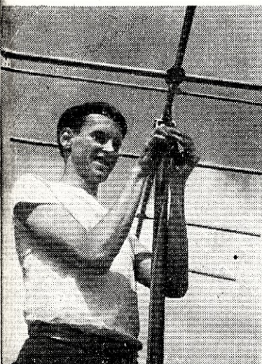
Andrzej Palut montuje antenę zespołu SP5KAB na pasmo 144 MHz
